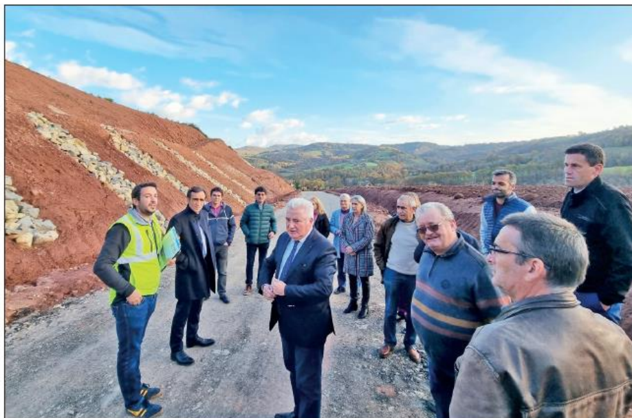
Visite du chantier du carrefour de la RD46 et de la RD904. ©Nina Vinches CD12
