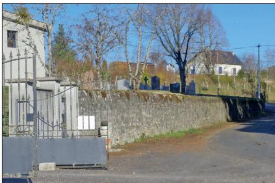
Le mur du cimetière côté sud.
